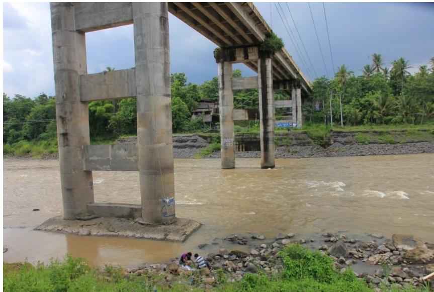
Gambar 1.1 Pilar Jembatan Kebon Agung II
