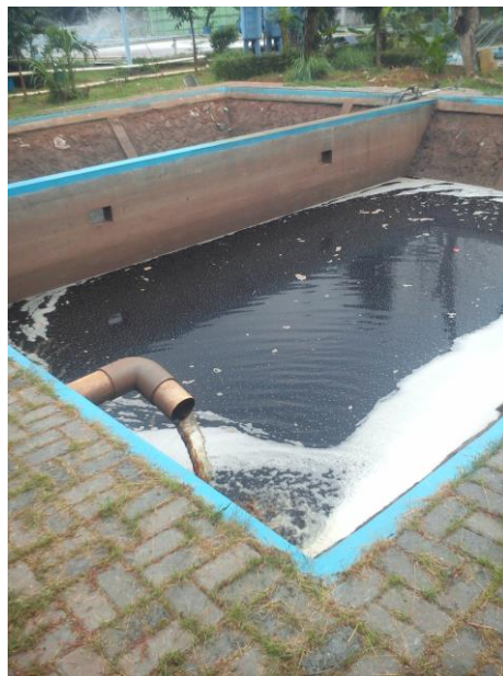
Gambar 1.2 Bak Penampung Awal IPAS 3 Bantar Gebang
