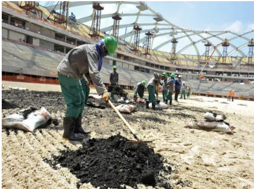
Pengerjaan Konstruksi dan Fasilitas Piala Dunia Qatar 2022
