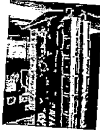
Gambar 2.6. Rangka Pembagi Utama
