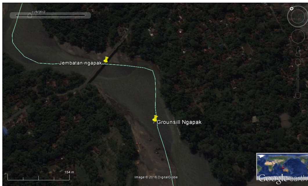
Gambar 1.1 Groundsill Ngapak tertutupi oleh sedimen berdasarkan google earth 2012.
