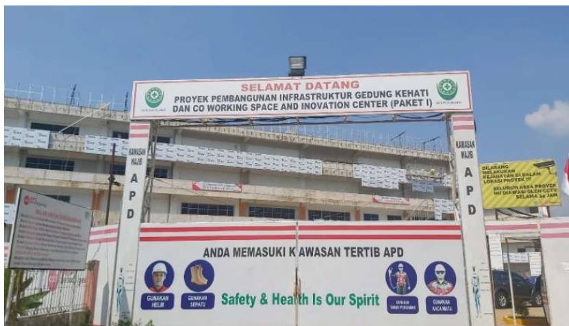
Gambar 1.3 Proyek pembangunan PT.Davitama Kreasi Sumber : Dokumentasi PT. Davitama Kreasi tahun 2021
