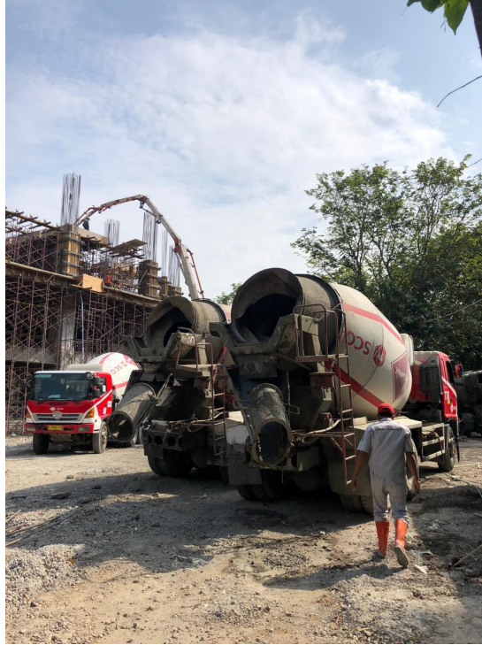
Gambar 3.2 Beton ready mix yang diangkut menggunakan mixer truck .
