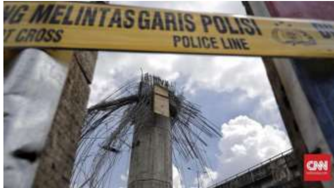
Gambar 1.1 ambruknya salah satu tiang pancang pada proyek pembangunan Tol Bogor outer Ring Road
