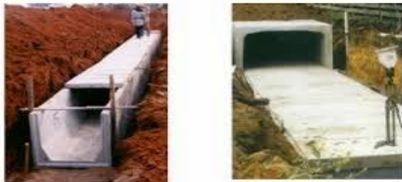
Gambar 4 Drainase saluran tertutup (sumbe : http://umarcivilengineering.blogspot.co.id/2015/02/drainase-perkotaan.html ).
