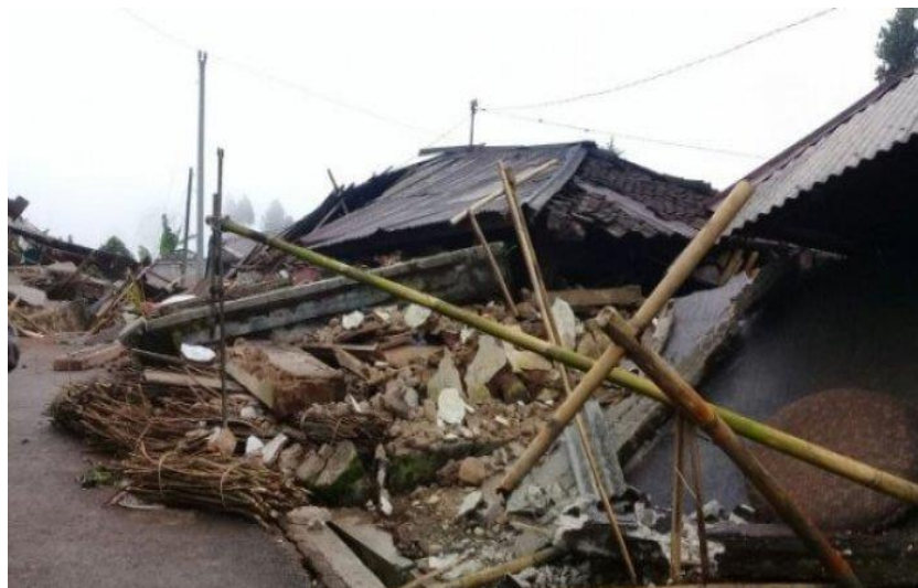
Gambar 1.2 Kerusakan bangunan akibat gempa di Kecamatan Wanayasa (Tribun Jogja, 2018)
